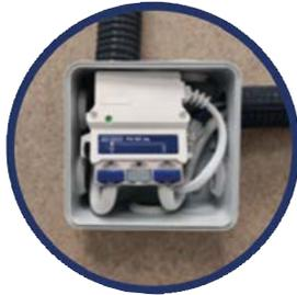
Installazione in scatola di giunzione 80x80mm
