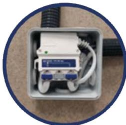
Installazione in scatola di giunzione 80x80mm
